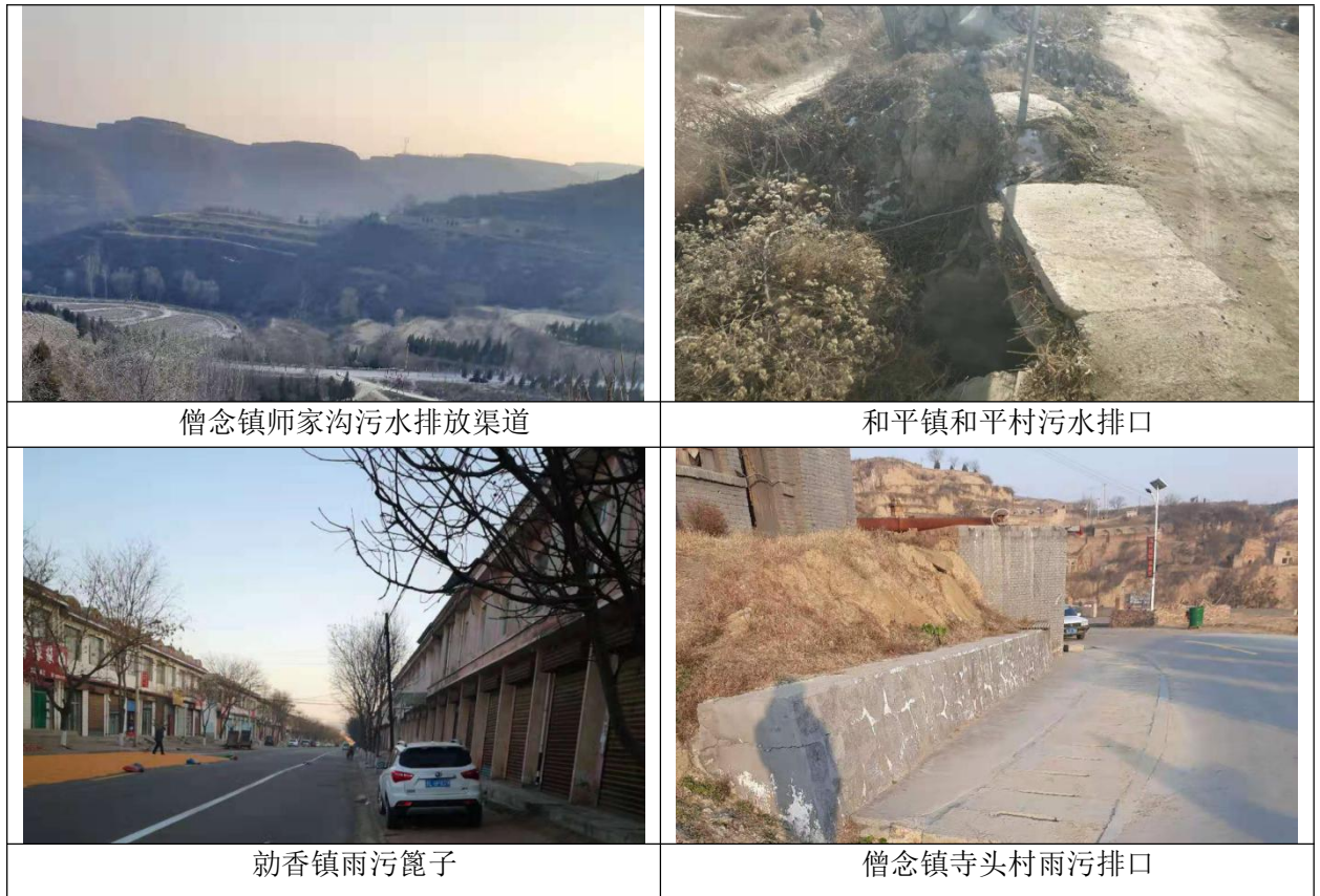
图 3-1 污水管网铺设现状
